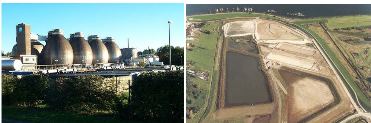
Abb. 7-21: (a) Kläranlage Seehausen (TEUTEBERG, 2005) und (b) Baggergutdeponie Seehausen (SENATOR FÜR BAU, UMWELT UND VERKEHR BREMEN, 2003)
