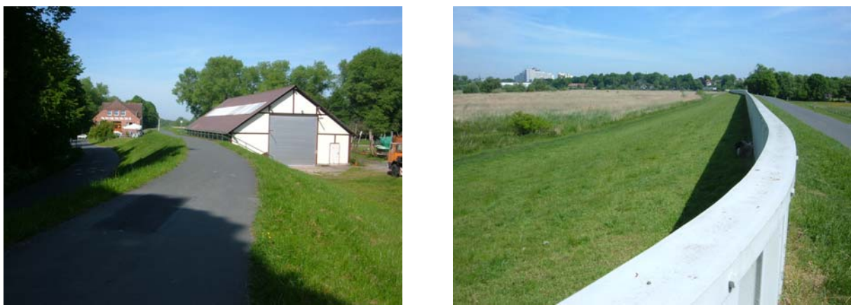
Abb. 7-2: (a) Lesumdeich vor dem Sperrwerk (b) Weserdeich mit Spundwand
